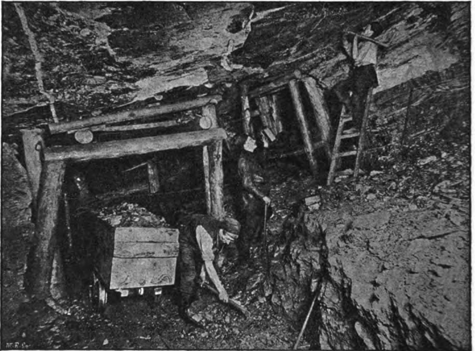
Fig. 6. Abbaubetrieb. Letzter Pfeiler aus Bremsberge.
