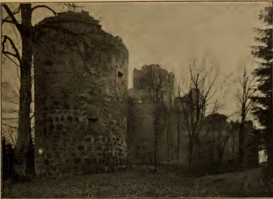
Fig. 7. Oestliche Burgmauer, Blick in den Halsgraben.
