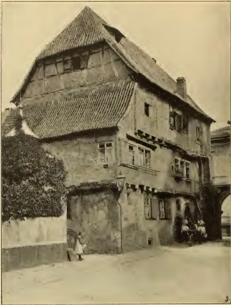
Fig. 115. Haus an der östlichen Stadtmauer zu Eberbach.
