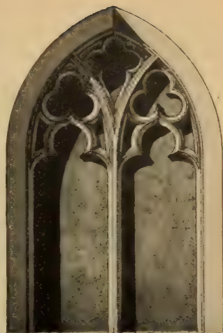
Fig. 30. Chorfenster in der Stadtkirche zu Mosbach.
