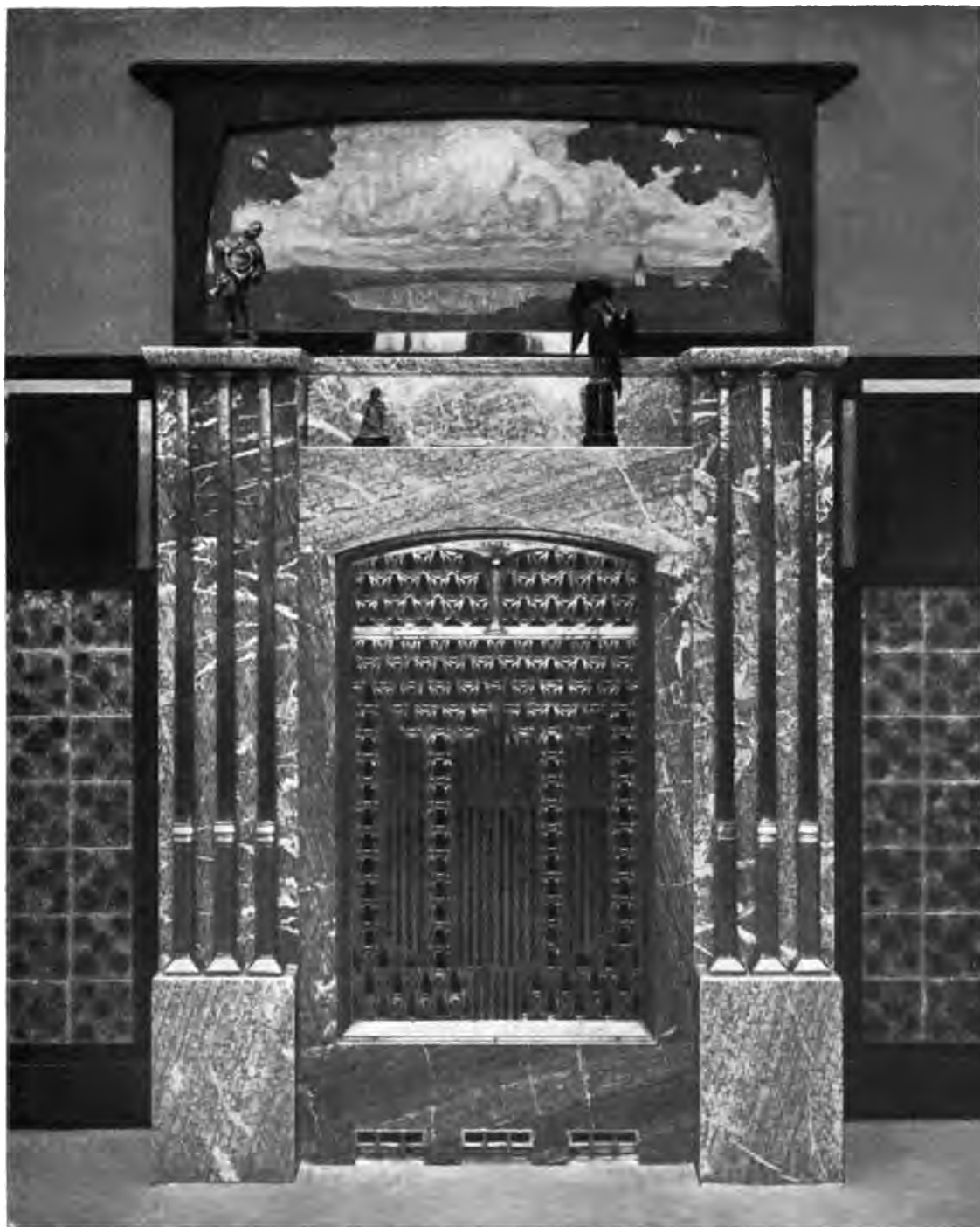
KAMINWAND. ARCHITEKT: A. GRENANDER, BERLIN.
