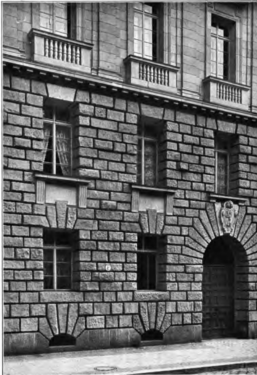
Lehrerwohnhaus in der Emdenerstrasse. Architekt: LUDWIG HOFFMANN in Berlin.
