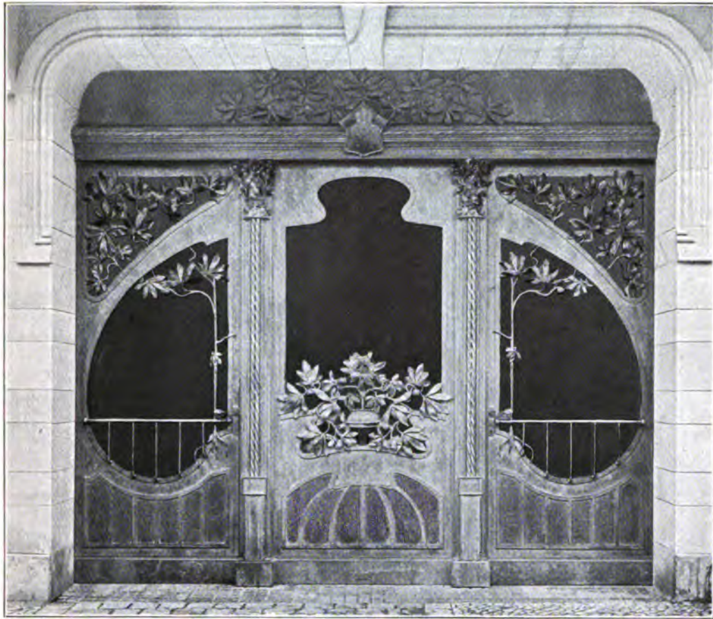
Dreiteiliges Thor am Hause Rheinstrasse 25 in Friedenau. Architekt: F. FEDLER in Charlottenburg. Ausführung: H. KLEMM, Kunstschlösser in Friedenau.
