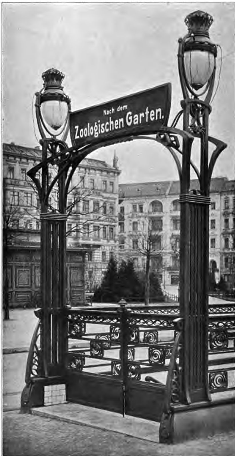
Eingang zur Haltestelle Wittenbergplatz (U- ntergrundbahn ). Architekt: ALFRED GRE N ANDER in Berlin.
