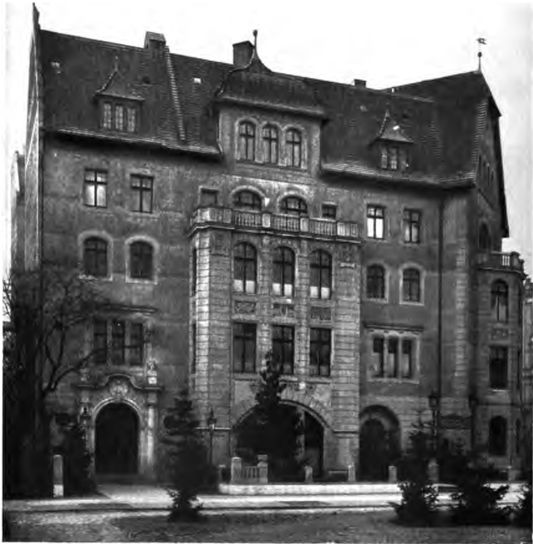
DAS NEUE MOTIVHAUS IN CHARLOTTENBURG. ANSICHT VON DER HARDENBERGSTRASSE. ARCHITEKTEN: REIMER UND KÖRTE IN BERLIN.
