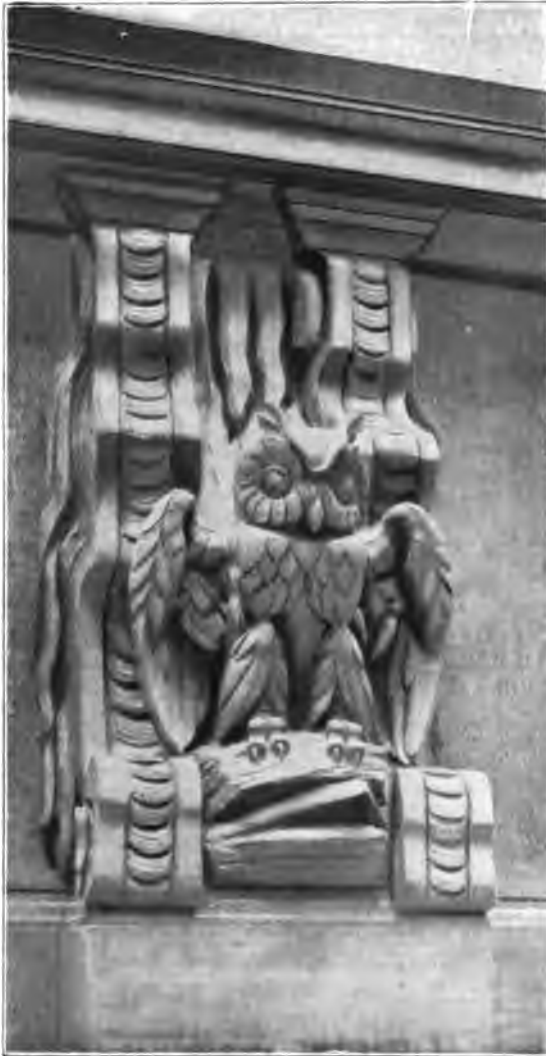
Mittelpfeiler im obersten Stockwerk.
