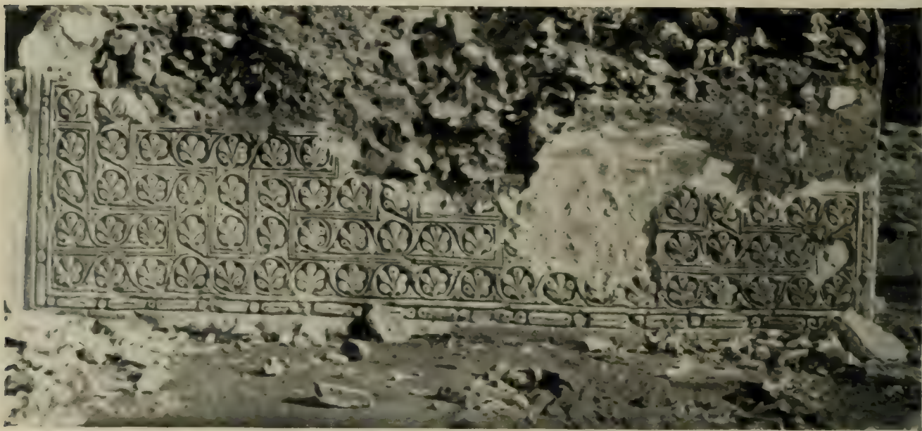
Abb. 164: Samarra, Stuckierte Wand.
